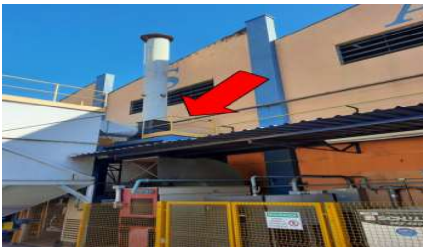
Figura 5: Exaustor de Fuligens cujo motor foi o ativo de estudo.
