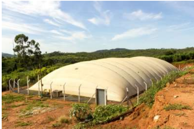
Figura 11. Exemplo de tratamento de efluentes por uso de biodigestor.
