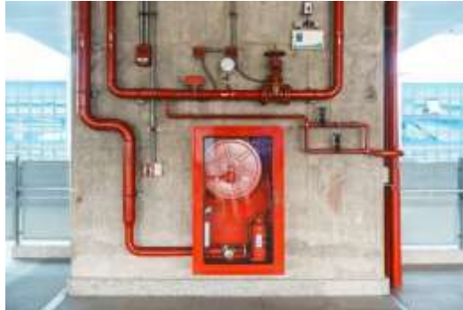
Figura 03: Extintor de incêndio e sistema de bomba de água
