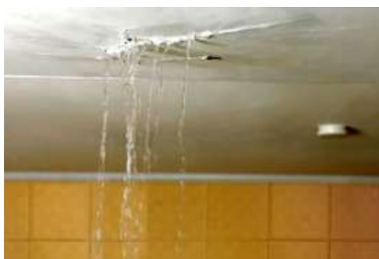
Figura 04- Vazamento sanitário
