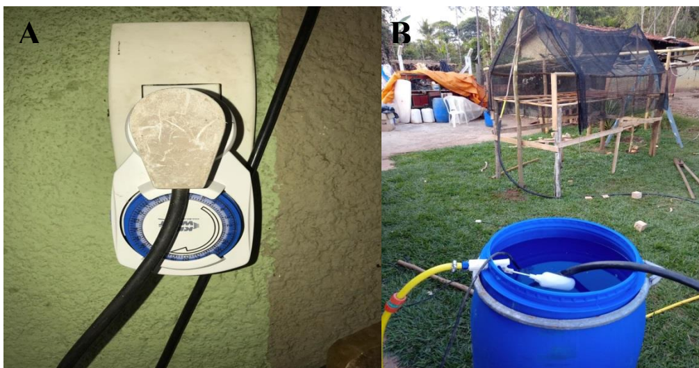
Figura 3 – A) Temporizador, para ligar e desligar a bomba d'água automaticamente. B) Tambor de 170 L com boia flutuante e bomba d'água de 1 CV.
